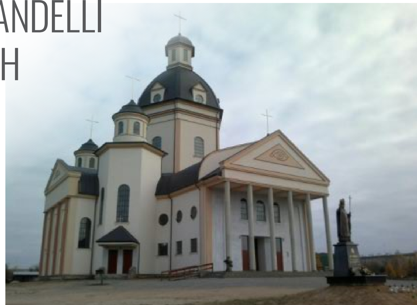
Kościół pw. Opatrzności Bożej w Parczewie zamontowano ogrzewanie podłogowe Prandelli
